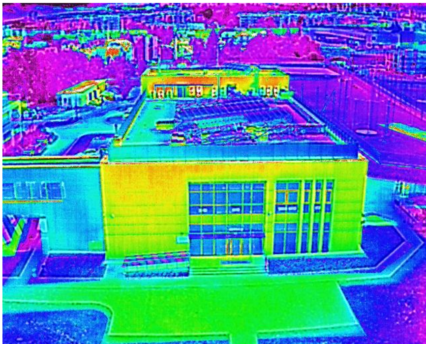
Foto 9. Budynek CENWIS w termowizji. Foto LPNiOZE.
