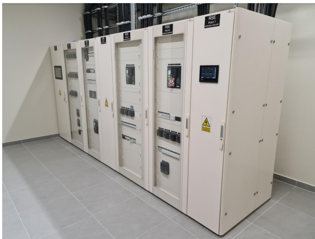
Foto 4. Akwizycja danych pomiarowych i rozdzielnia systemu elektroenergetycznego RSE integrująca odbiory i źródła energii, wchodząca w skład Mikrosieci Elektroenergetycznej. Foto LPNiOZE.
