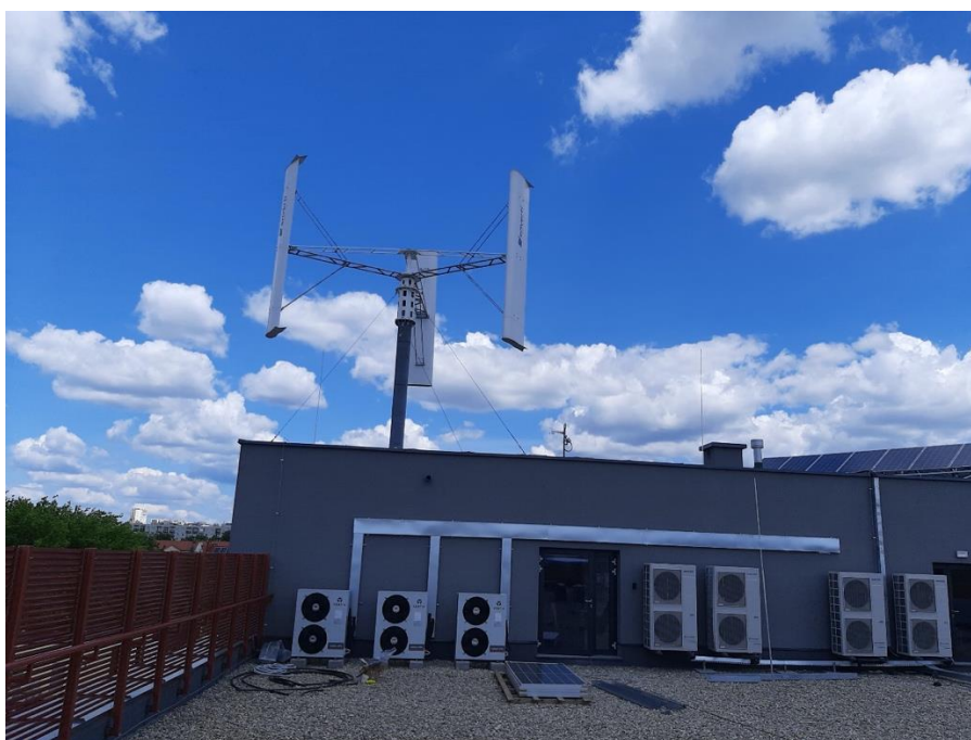
Foto 6. Jedna z 6 turbin wiatrowych z osią pionową o mocy 6 kW zlokalizowana na dachu budynku Cenwis, wchodząca w skład Mikrosieci Elektroenergetycznej. Foto LPNiOZE.
