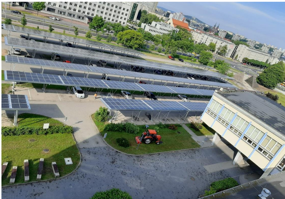
Foto 1. Instalacja fotowoltaiczna na karporthach moc 0,5 MWp, wchodząca w skład Mikrosieci Elektroenergetycznej. Foto LPNiOZE.
