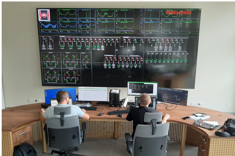
Foto 3. Centrum dyspozytorskie do monitorowania produkcji i dystrybucji energii pozyskiwanej z nisko- i zero-emisyjnych źródeł energii, wchodzące w skład Mikrosieci Elektroenergetycznej. Foto LPNiOZE.
