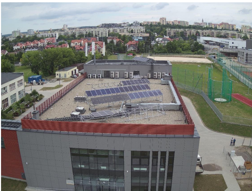
Foto 2. Badane moduły fotowoltaiczne wykonane w różnych technologiach
