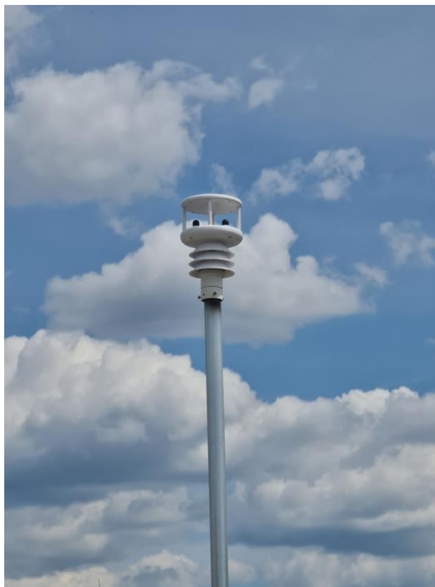
Foto 5. Stacja pogodowa wchodząca w skład Mikrosieci Elektroenergetycznej. Foto LPNiOZE.
